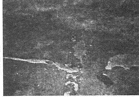
Resim 6. Banyo taban blok kabuklanmaları.
